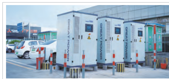
广州某大型超市
