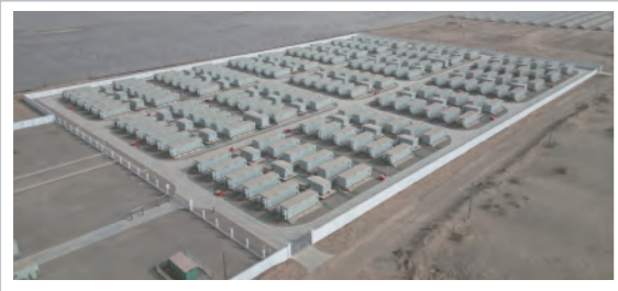
中石油塔里木油田伽师县600MWh光伏发电项目
