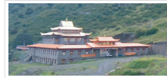
四川康定 392kWh 光储离网储能项目
